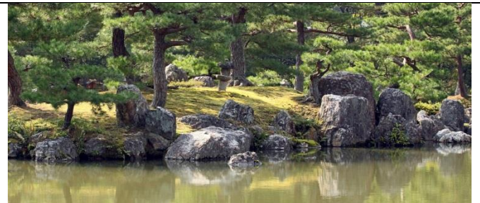
4 鹿苑寺（AD1397・京都市）；護岸の本格的石組
